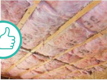
**INSULATION FILLS CAVITY, PROPERLY SUPPORTED**
